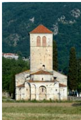
Clocher (Saint-Just de Valcabrière, Haute-Garonne)
